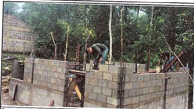
Foto 2: Cocina: Terminación de levantado del muro de la pared de la cocina de la mitad hasta la coronación
