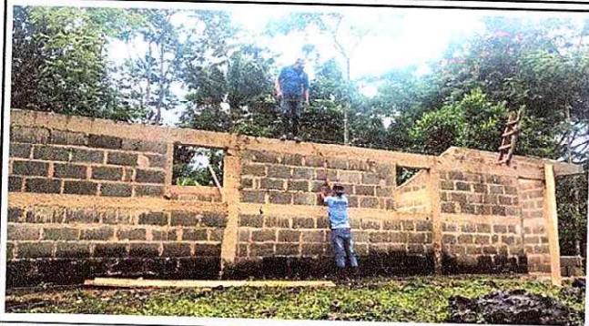
Foto 1: Aula Antigua: Inicio del reforzamiento de la coronación, de fundición de terminación de pared y las columnas de la puerta principal
