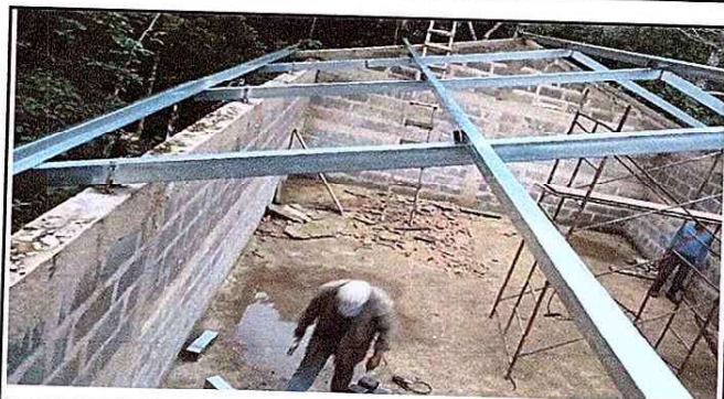
Foto 4: Cocina Estructuración del entechado de la cocina previo a la colocación de laminas.
