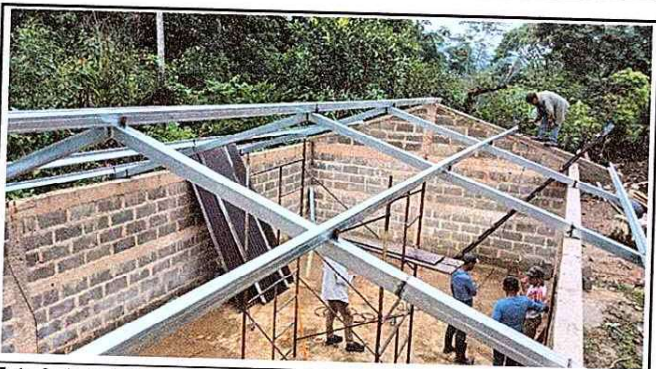
Foto 3: Aula Antigua: Proceso de la estructuración del entechado
